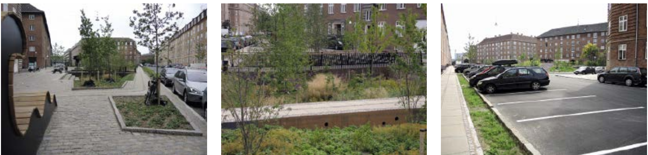
Abb. 1: Der neugestaltete Tåsinge Plads mit dem tiefergelegten und bepflanzten Versickerungsbecken.
