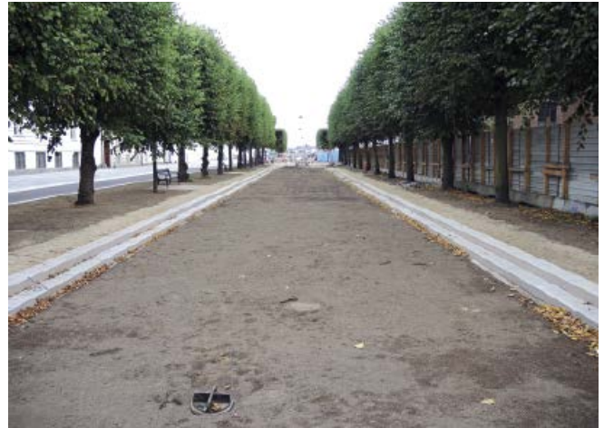
Abb. 2: Baumaßnahmen in der historisch geprägten Innenstadt. Links: Einbau straßenparalleler Entwässerungsrinnen zur Verbesserung der Wasserableitung, die jedoch kritisch diskutiert werden. Rechts: Tieferlegung des historischen Sankt Annæ Plads für den temporären Rückhalt von Regenabflüssen, bevor das Wasser ins nahegelegene Hafenbecken geleitet wird. Die Fläche in der Mitte wird noch mit überflutungstoleranten Stauden bepflanzt (Einweihung: Juni 2016).
